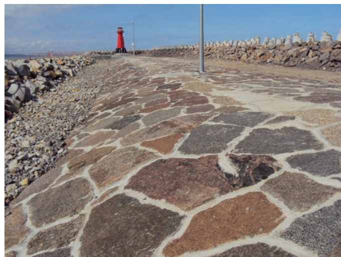
Rys. 17. Widok na wyremontowany dawny korpus
