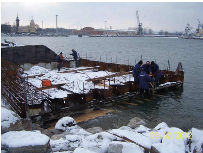
Rys. 13. Wykonywanie oczepu grodzki u nasady falechronu
