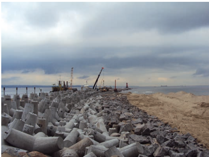
Rys. 12. Kolejne etapy prac
