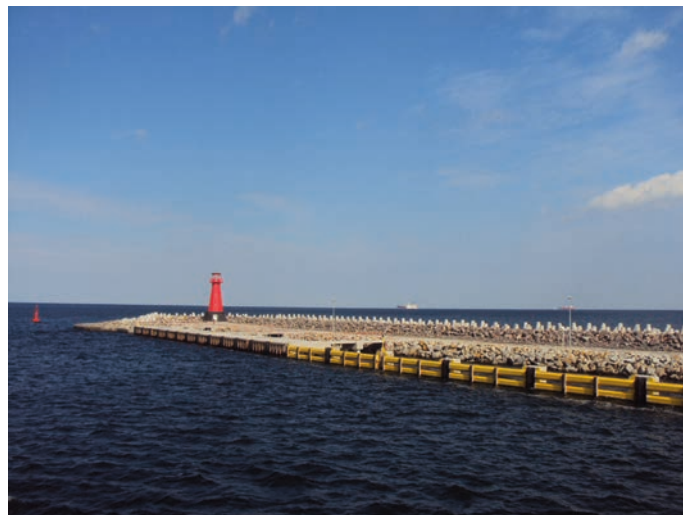
Rys. 15. Falechron po przebudowie
