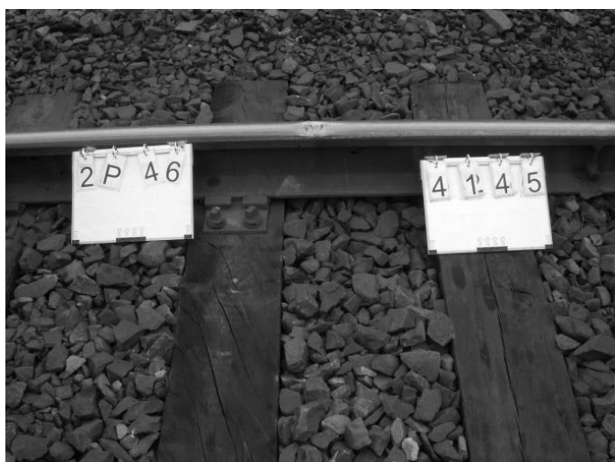
Rys. 8. Wada squat – brak przytwierdzenia szyny do podkładu
