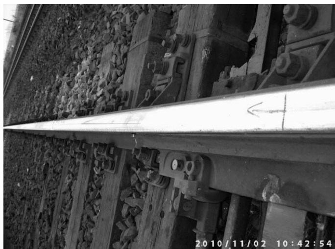
Rys. 12. Wady head check na powierzchni tocznej opornicy
