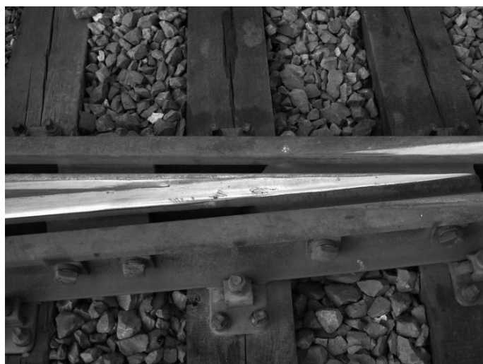
Rys. 13. Uszkodzenia na powierzchni dzioba krzyżownicy
