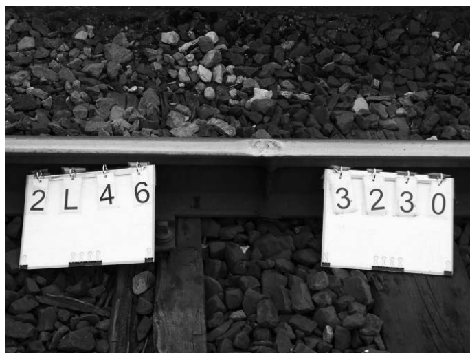
Rys. 6. Wada squat w strefie złącza
