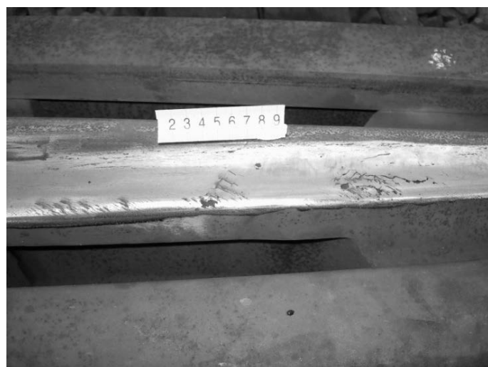
Rys. 13. Uszkodzenia na powierzchni dzioba krzyżownicy
