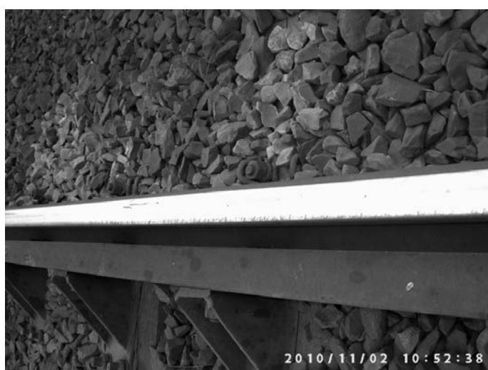
Rys. 16. Uszkodzenia head check na powierzchni tocznej szyny przy kierownicy
