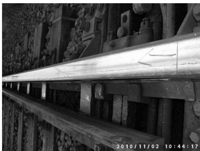
Rys. 14. Wady head check na powierzchni tocznej opornicy
