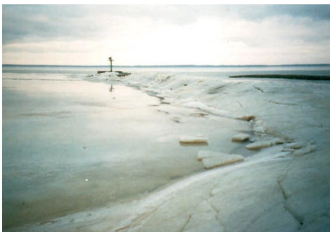
Rys. 2. Nasunięte pole lodowe na umocnienia brzegowe portu w Tolknicku (Zalew Wiślany, 11 II 2011 r.)
