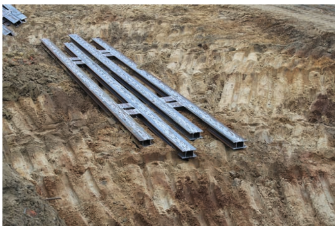
Rys. 5. Budowa Nowego Centrum Sopotu. Kleszcze górnego poziomu
