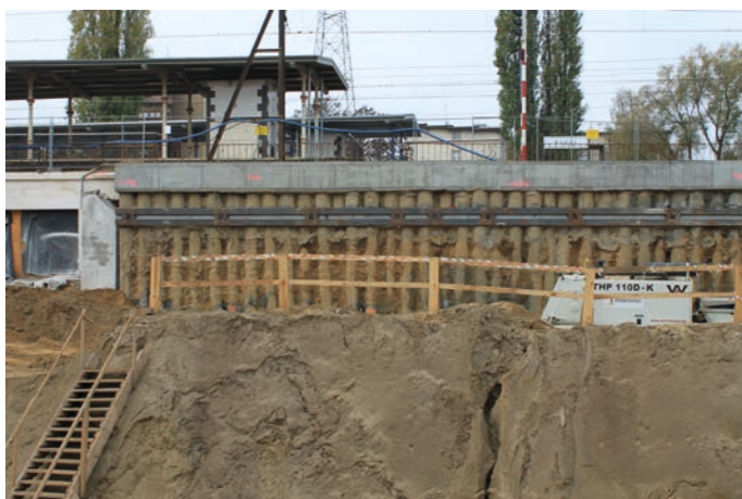
Rys. 6. Budowa Nowego Centrum Sopotu. Wykop – I faza
