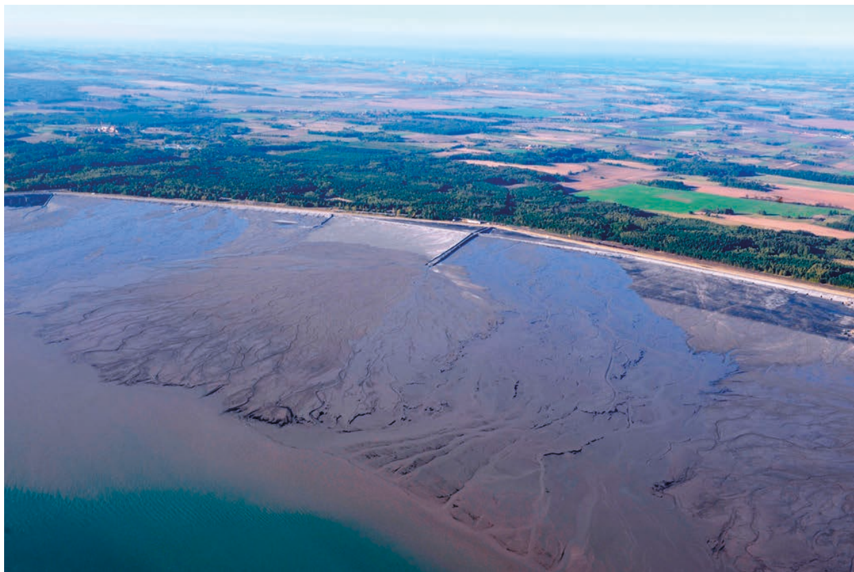
Rys. 2. Namywanie sekcji na OUOW Żelazny Most (fot. archiwum KGHM O/ZH)
