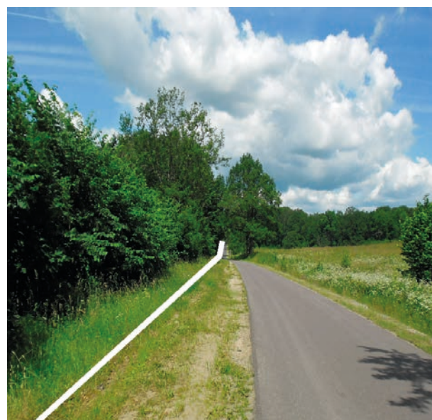
Rys. 7. Droga po przebudowie - widok w kierunku północnym (białą linią zaznaczono dawną krawędź drogi)
