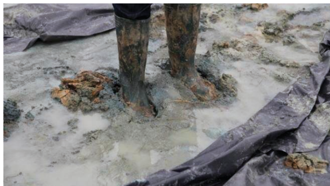
Rys. 4. Zdegradowana przez mróz warstwa kompozytu łąowo-cementowego pod folią
