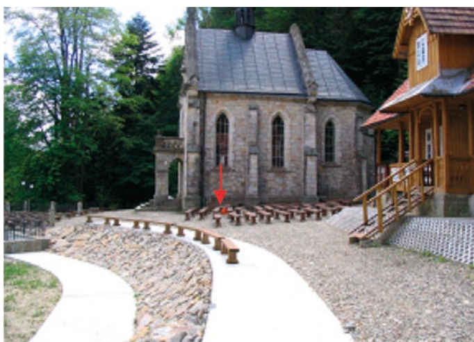
Rys. 5. Teren przy kaplicy stabilizacji – widoczny punkt monitoringu
