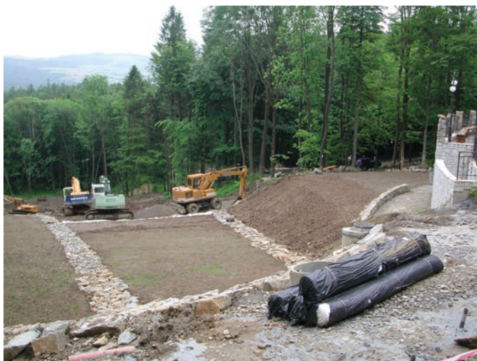
Rys. 6. Budowa systemu drenażu osuwiska
