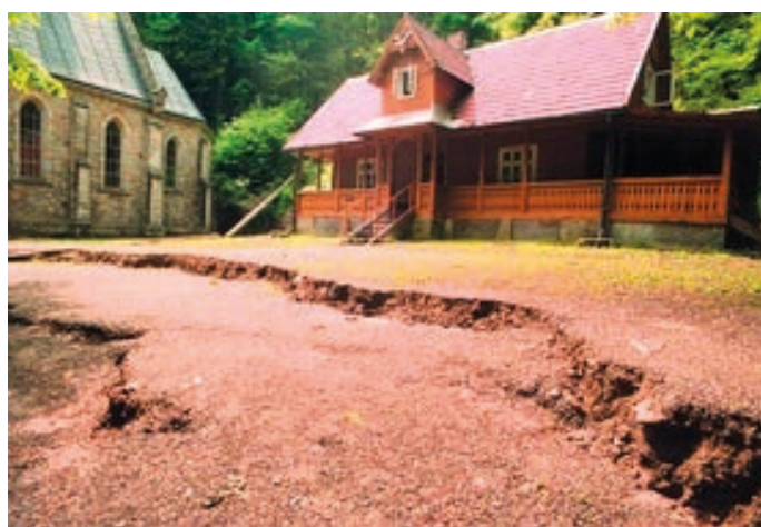
Rys. 3. Skarpa główna osuwiska, przy kaplicy i domu pielgrzymów (2005)
