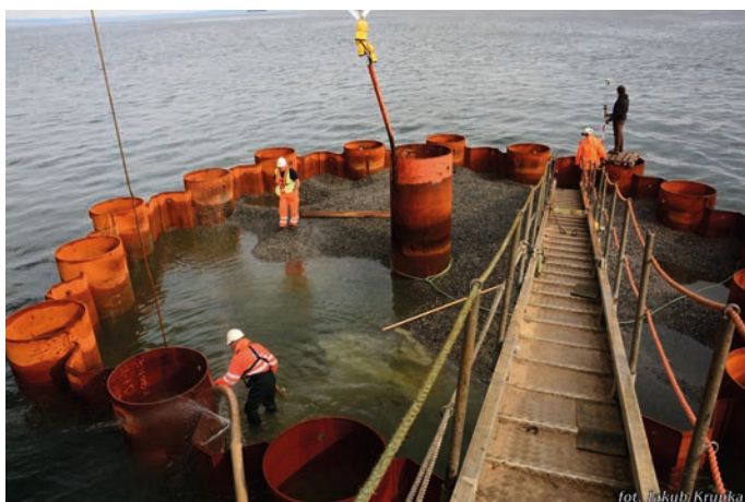
Rys. 14. Zasyp wnętrza grodzii fundamentu stawy
