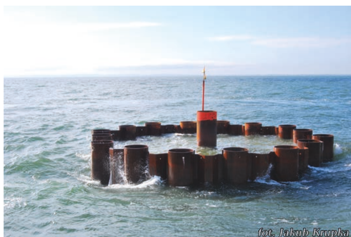
Rys. 5. Wykonany fundament stawy nabieżnikowej
