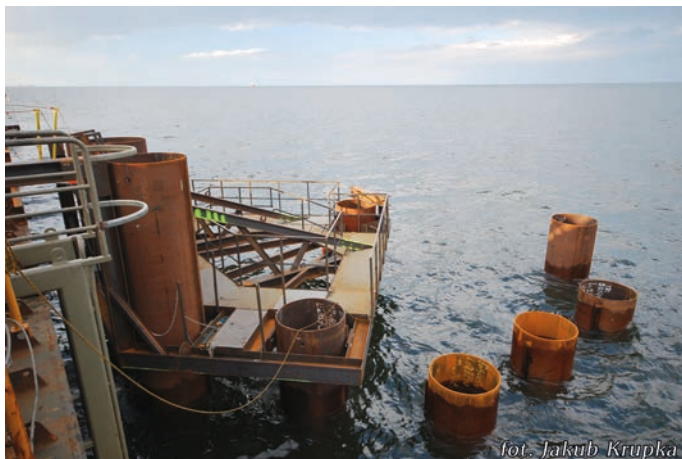
Rys. 12. Pograżanie pali rurowych z użyciem szablonu
