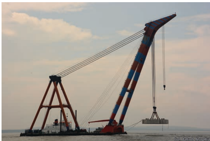
Rys. 18. Transport dźwigiem pływającym dolnego prefabrykatu stawy
