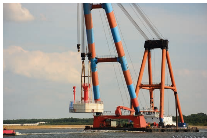
Rys. 22. Transport dźwigiem pływającym górnego prefabrykatu nadbudowy stawy
