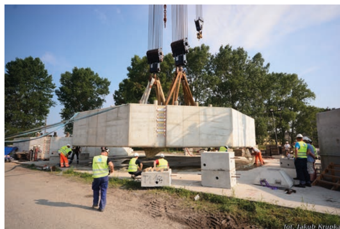
Rys. 17. Unoszenie dźwigiem pływającym dolnego prefabrykatu po jego wykonaniu na nabrzeżu
