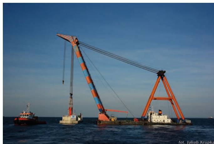
Rys. 23. Zmontowana z żelbetowych prefabrykatów nadbudowa stawy z asystą dźwigu pływającego
