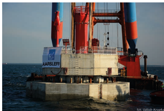
Rys. 8. Osadzanie (przy użyciu dźwigu pływającego) górnego prefabrykatu nadbudowy stawy
