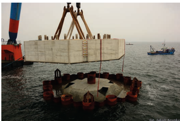
Rys. 20. Osadzenie (przy użyciu dźwigu pływającego) dolnego prefabrykatu nadbudowy na koronie fundamentu stawy (palościance)
