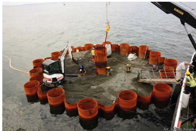
Rys. 15. Wykonywanie podbudowy pod dolny prefabrykat
