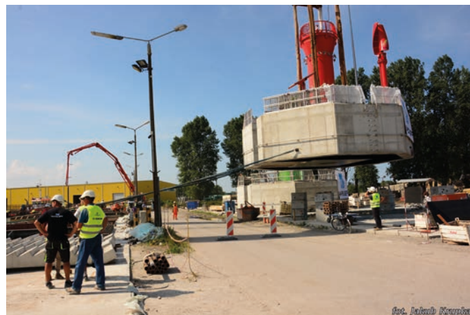
Rys. 21. Unoszenie dźwigiem pływającym górnego prefabrykatu po jego wykonaniu na nabrzeżu
