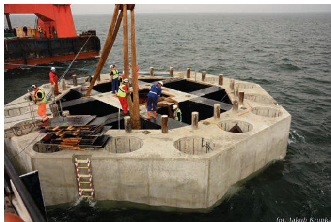
Rys. 7. Dolny prefabrykat nadbudowy tuż po jego osadzeniu na fundamencie stawy
