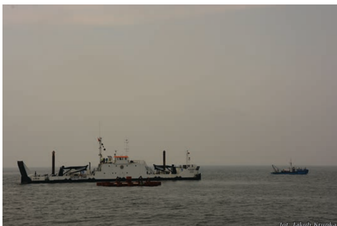
Rys. 19. Wykonany fundament stawy z roboczym statkiem obsługowym
