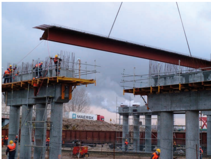
Rys. 1. Prace montażowe przy budowie wiaduktu WD-7 na Trasie Sucharskiego w Gdańsku
