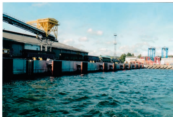
Rys. 6. Widok nabrzeża Szwedzkiego po przebudowie na styku z nabrzeżem Duńskim po remoncie
