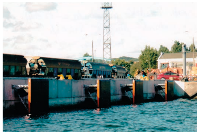
Rys. 5. Widok od strony wody na nabrzeże Szwedzkie po przebudowie
