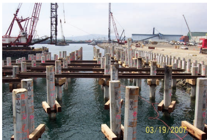
Rys. 9. Roboty palowe, Etap 2
