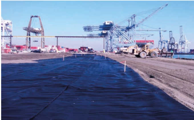
Rys.11. Stabilizacja podłoża pod nawierzchnią portową, Etap 2
