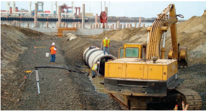
Rys. 10. Konstrukcja rurociągu poniżej wody gruntowej, Etap 2
