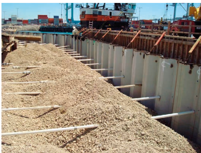
Rys. 6. Zakotwienie ścianki szczelinowej, Etap 3
