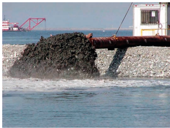
Rys. 2. Budowa Nasypu - metoda muszlowa (clamshell) i hydrauliczna, Etap 1
