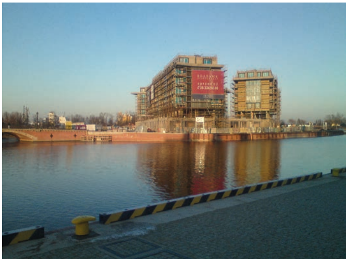
Rys. 10. Widok na nabrzeża w końcowym etapie robót (z lewej strony widoczne ujęcie rzeki Raduni pod mostem Wapienniczym)
