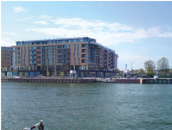
Rys. 8. Nabrzeże od strony Kanału Motławy z widokiem na wnękę (w miejscu dawnej wnęki przystani promowej) – z prawej strony widoczne, wcześniej wykonane, nabrzeże z bulwem przy ul. Wiosny Ludów
