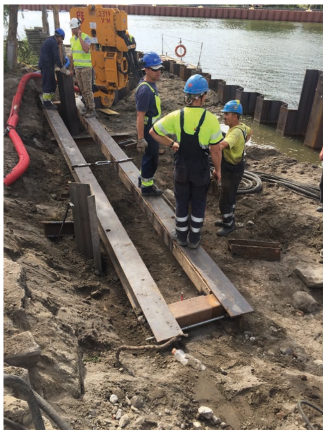
Rys. 4. Zapuszczanie tylnej ścianki szczelnej z wykorzystaniem kleszczy prowadzących ułożonych na gruncie
