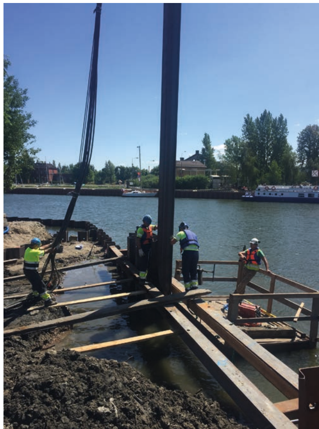
Rys. 5. Zapuszczanie czołowej ścianki szczelnej z wykorzystaniem kleszczy prowadzących
