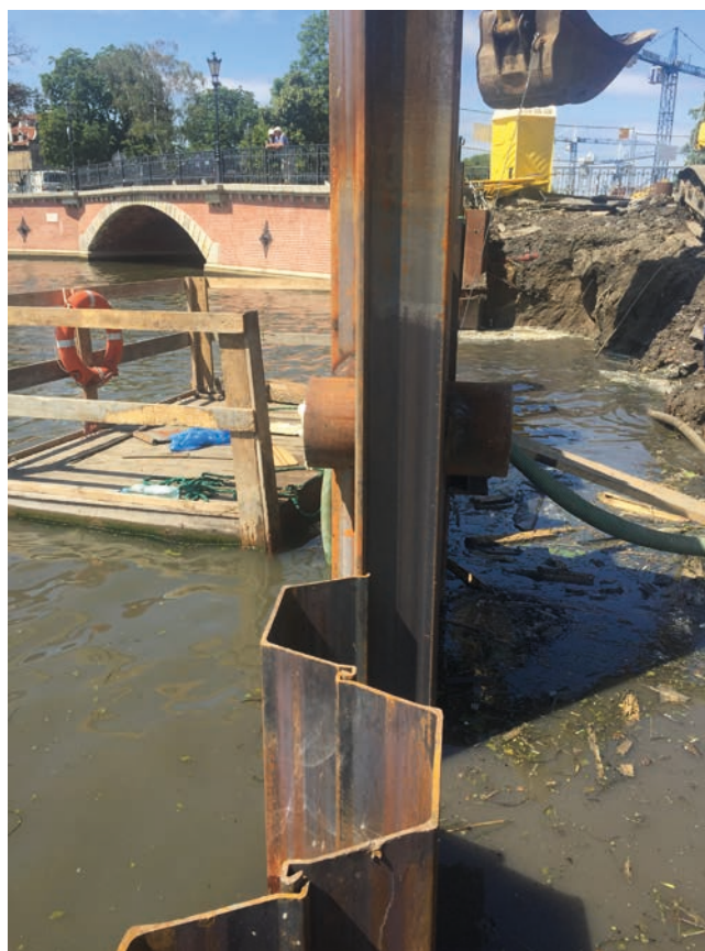
Rys. 6. Widok wyciągniętych brusów z zainstalowaną rurą osłonową dla rurociągu odprowadzania wody
