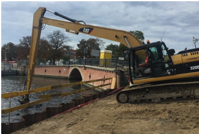
Rys. 2. Prowadzenie robót czerpalnych przy pomocy koparki usytuowanej na ładzie i załadunkiem urobku na samochód (w głębi widoczny zabytkowy most Wapienniczy z ujściem rzeki Raduni)
