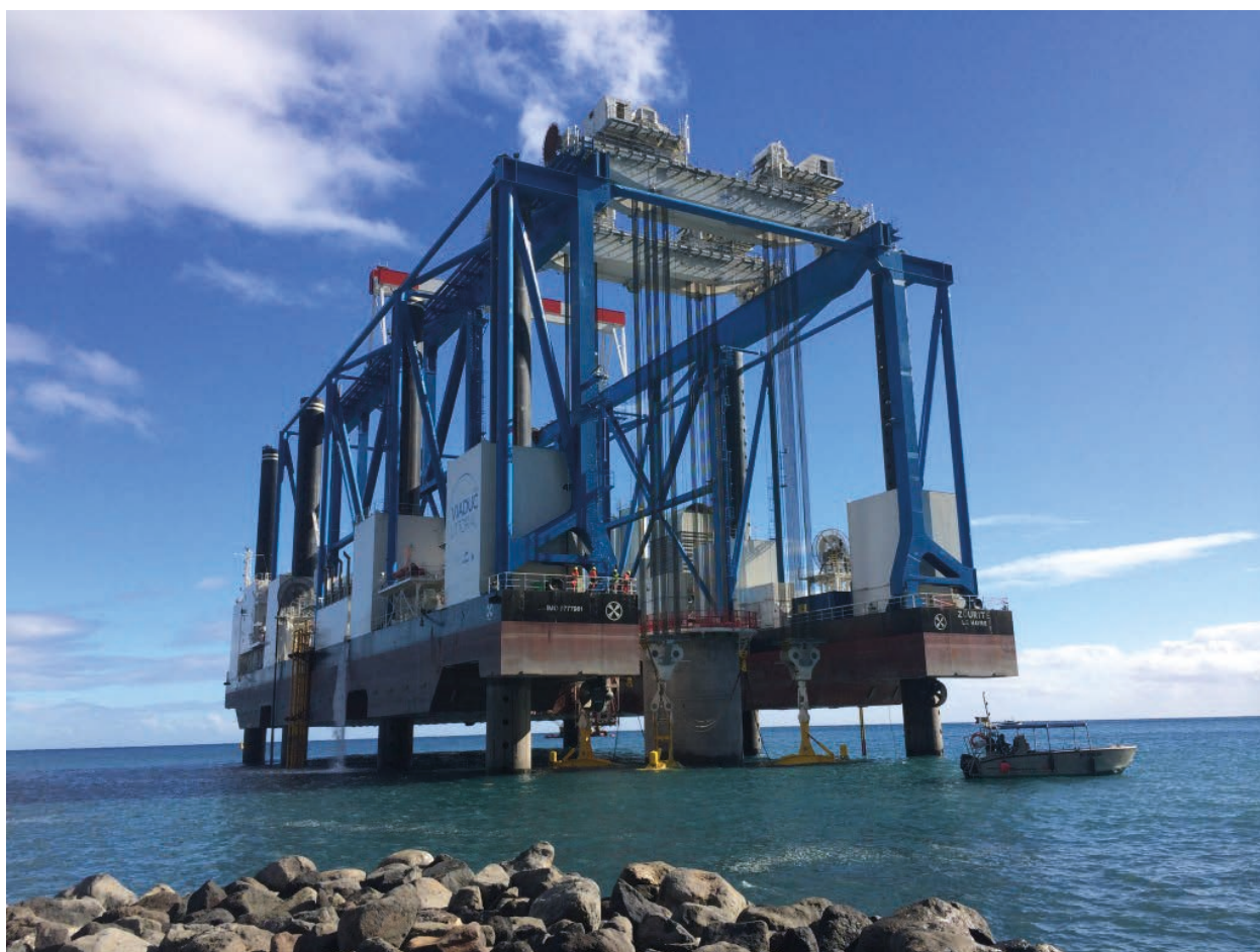
Rys. 10. Jednostka HLJB Zourite w trakcie opuszczania na dno fundamentu podpory estakady morskiej budowanej wzdłuż brzegu wyspy La Reunion, ważącego 4530 T
