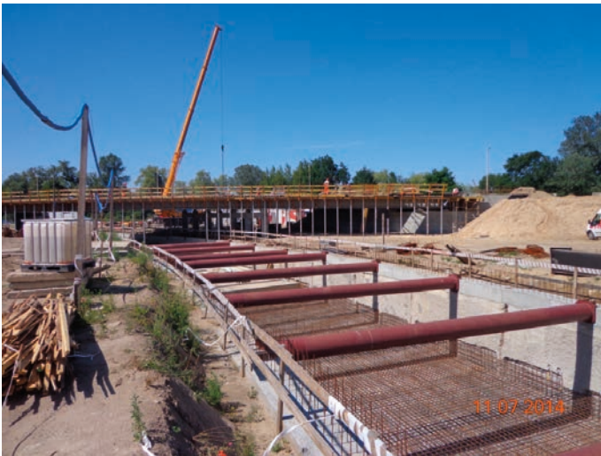
Rys. 2. Zabezpieczenie tymczasowe rozporami wykopu obudowanego wraz ze zbrojeniem płyty fundamentowej
