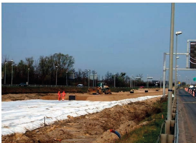
Rys. 6. Budowa nasypu tramwajowego na matacach z kruszywa i geotkaniny – rejon wzmocnienia podłoża kolumnami podatnymi MSC wzdłuż ulicy Eskadrowej [9]
