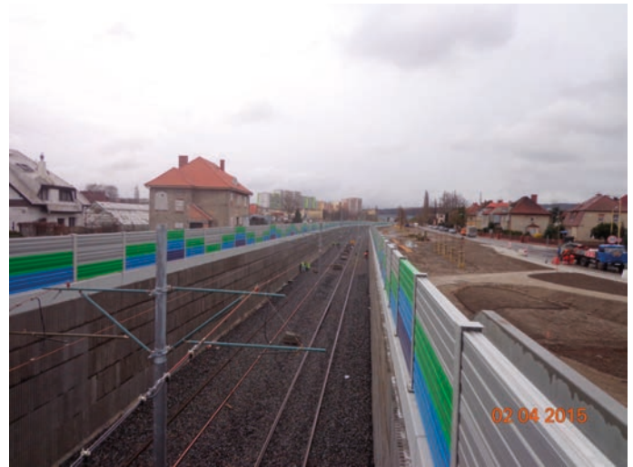
Rys. 3. Przygotowany do odbioru obudowany wykop Szczecińskiego Szybkiego Tramwaju – odcinek przy ulicy Batalionów Chłopskich
