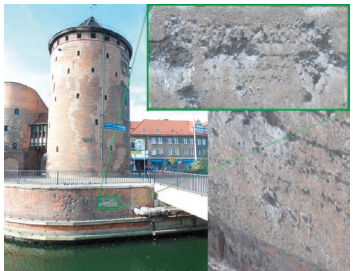
Rys. 6. Znak wielkiej wody przy Moście Stągiewnym w punkcie numer 4 (30.10.2011)
