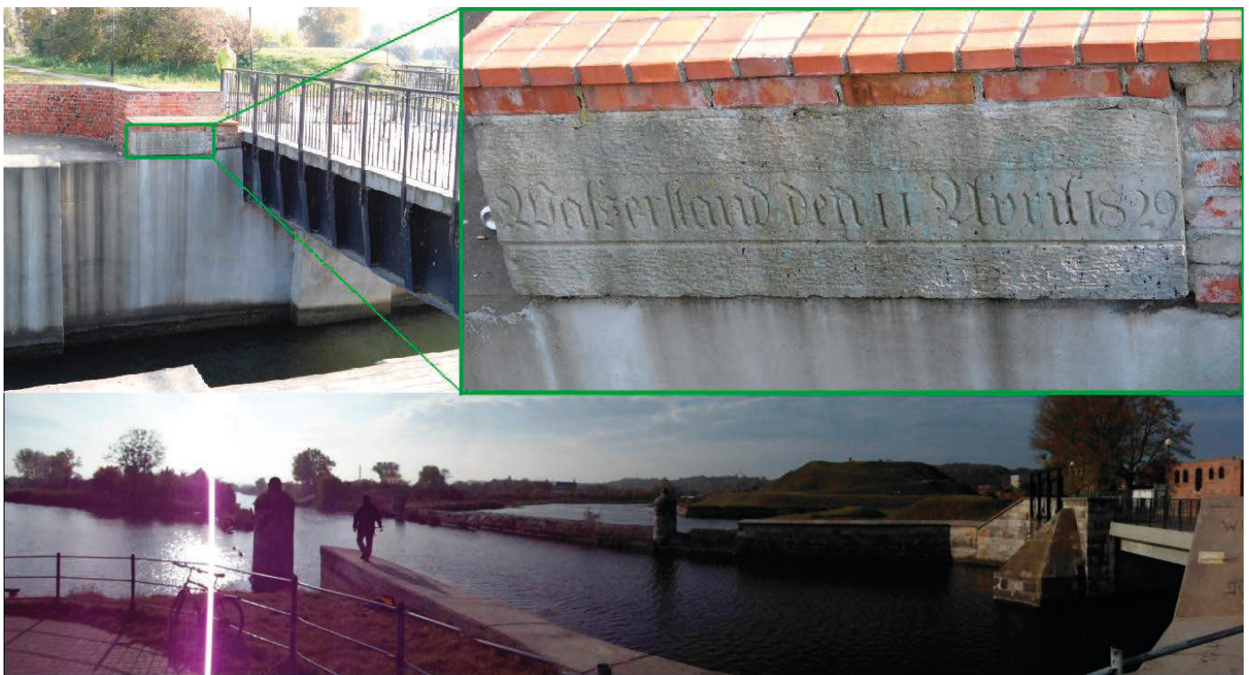
Rys. 8. Znak wielkiej wody na Kamiennej Śluzie w punkcie numer 6 (30.10.2011)
