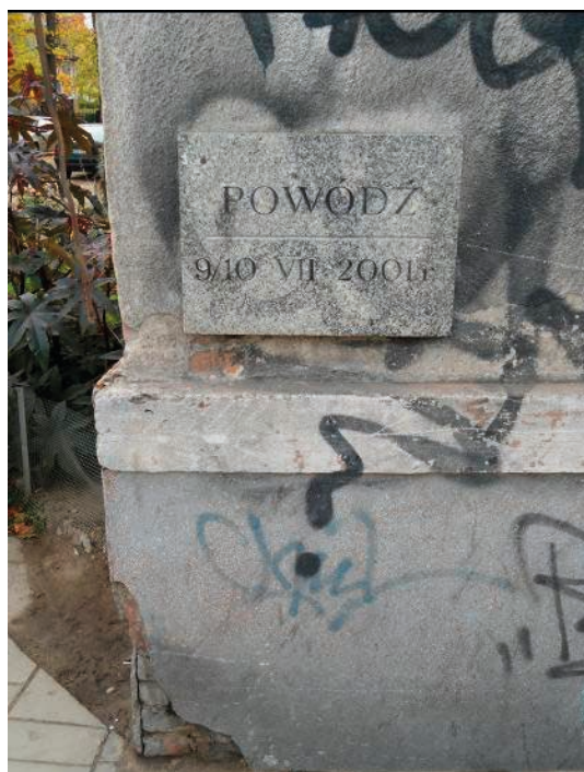
Rys. 10. Znak wielkiej wody na ul. Grunwaldzkiej 146A
