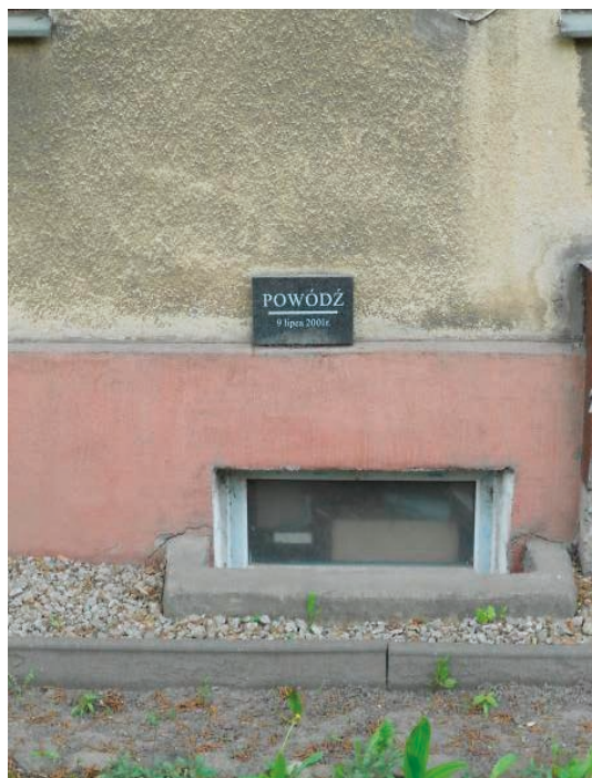
Rys. 9. Znak wielkiej wody na ul. Juliusza Słowackiego 70
