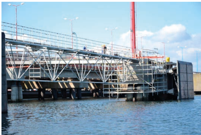
Rys. 7. Wiszące rusztowanie podczas remontu bloku podpory nr 1 (widoczna dalba odbojowa oraz pomosty komunikacyjne)
