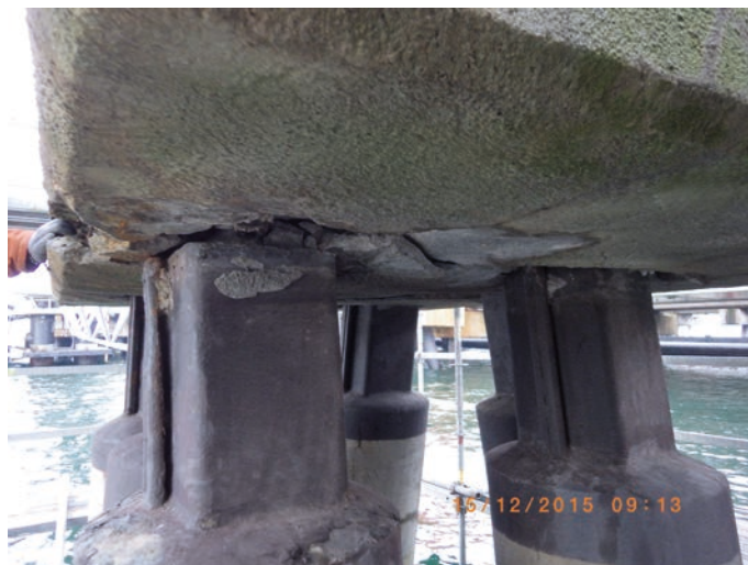
Rys. 6. Widok podpory nr 1 bezpośrednio przed podjęciem robót remontowych (widoczny brak połączenia głowicy pali z betonowym blokiem)
