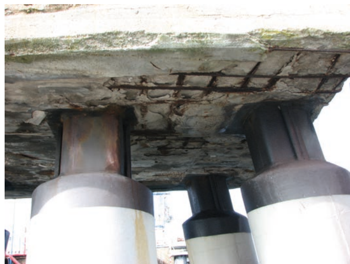
Rys. 4. Widok podpory nr 5 przed remontem (wyraźnie odsłonięte zbrojenie w dolnej części bloku wskutek korozji betonu)
