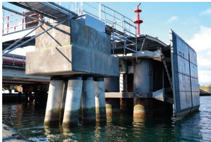
Rys. 9. Widok nadbudowy podpory nr 1 po wykonaniu remontu
