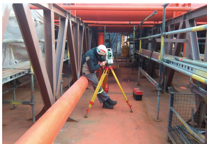
Rys. 6. Prace przygotowawcze do pomiarów geodezyjnych na pokładzie budowanej konstrukcji (fot. Firma U-H DIAZ)
