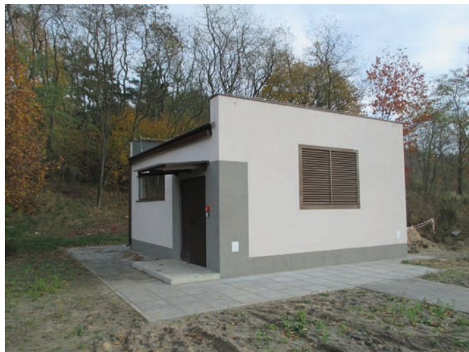
Rys. 14. Widok budynku agregatów prądotwórczych
