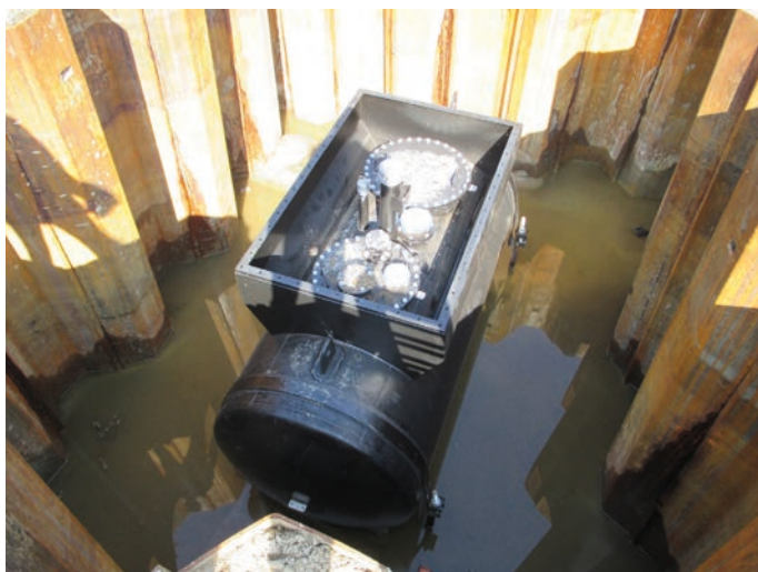
Rys. 10. Posadowienie zbiornika resztkowania obok SP w wykopie z obudową ze stalowej ścianki szczelnej.
