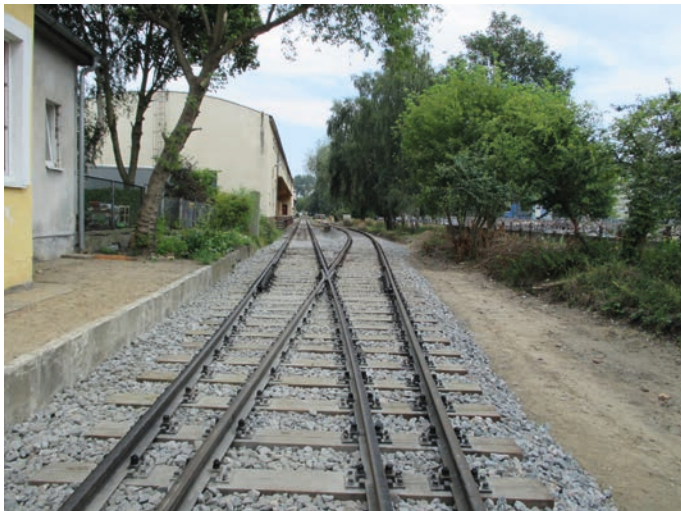
Rys. 16. Przebudowany układ torowy z rozjazdem
