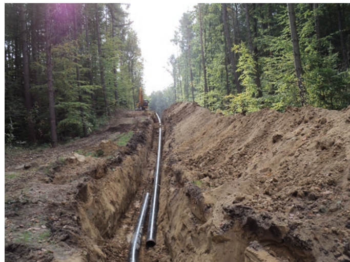
Rys. 1. Układanie rur na trasie rurociągu paliwowego
