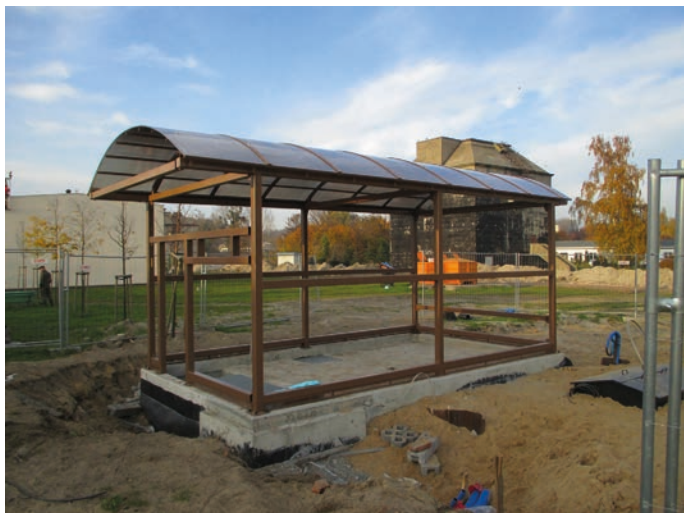
Rys. 12. Szkielet stalowy budynku Stacji Pomiarowej posadowionej na betonowej tacy fundamentowej (obok w zasypie widoczna górna część zbiornika resztkowego)
