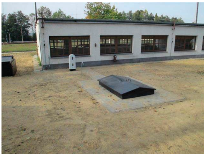
Rys. 6. Widok Pompowni ekspedycyjnej (przed budynkiem widoczny zbiornik buforowy)
