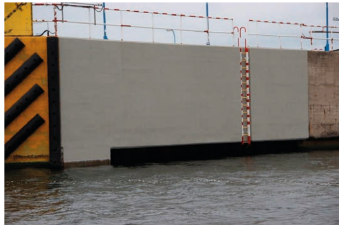
Rys. 11. Element pirsu po kompleksowej naprawie materiałami polimerowo-cementowymi
