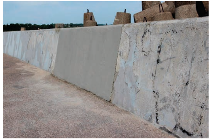
Rys. 9. Element falochronu po naprawach materiałami PCC
