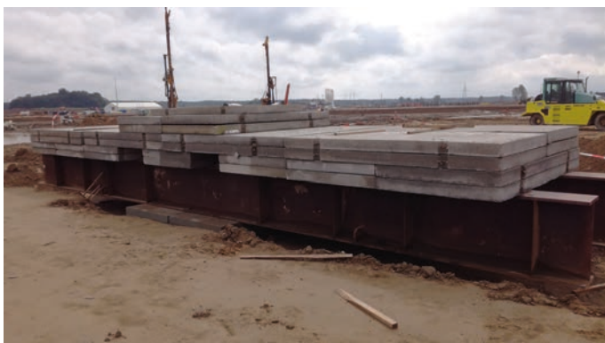
Rys. 2. Badanie statyczne z wykorzystaniem bloków betonowych (fot. własna)
