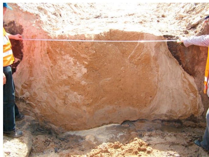
Rys. 2. Podstawa kolumny z kruszywa
