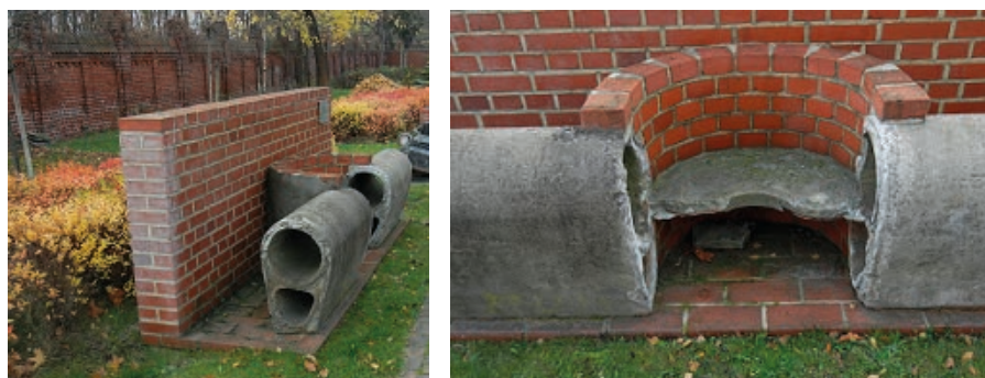
Rys. 4. Kanał piętrowy małej średnicy (betonowy)
