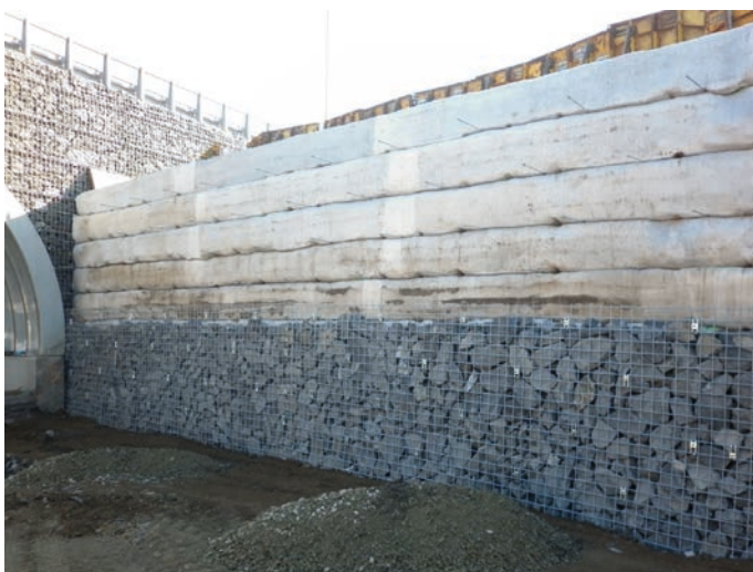
Rys. 8. Przykład oblicowania kamiennego instalowanego do samostatecznego bloku z gruntu zbrojonego geotkaninami, P.R. INORA
