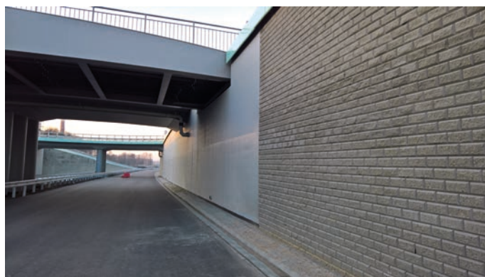
Rys. 11. Widok na ścianę oporową w technologii biernej po instalacji oblicowania, P.R. INORA
