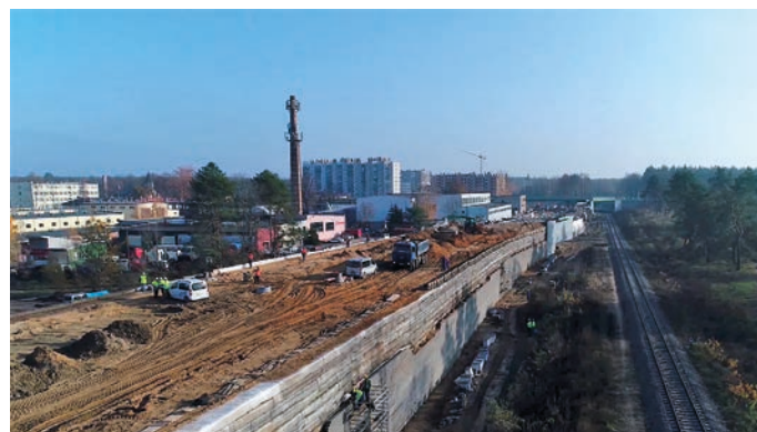
Rys. 10. Wznoszenie samostatecznego bloku z gruntu zbrojonego, P.R. INORA
