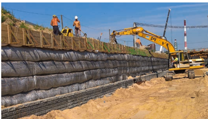
Rys. 7. Instalacja drobnowymiarowych bloczków betonowych po wzniesieniu bloku z gruntu zbrojonego, P.R. INORA
