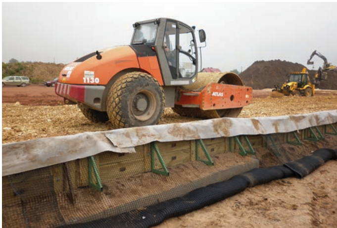
Rys. 6. Zagęszczanie zasypki przy samej krawędzi bloku z gruntu zbrojonego w technologii biernej, P.R. INORA [25]
