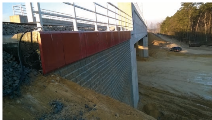
Rys. 14. Przykład skrzydła z gruntu zbrojonego przy wiadukcie kolejowym, P.R. INORA
