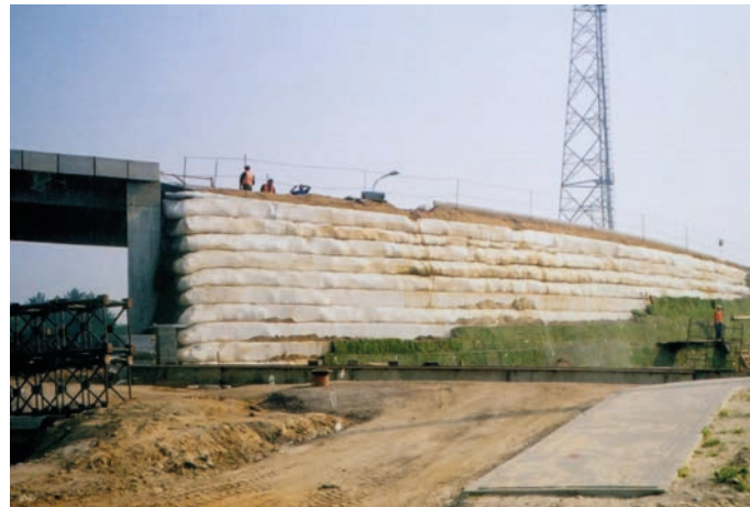
Rys. 9. Oblicowanie rampy dojazdowej do obiektu mostowego za pomocą systemowej okładziny trawiastej, P.R. INORA
