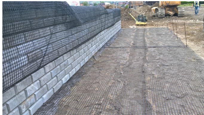
Rys. 13. Wkładka geosyntetyczna zbrojąca grunt oraz jednocześnie kotwiąca element licujący w technologii aktywnej, widok od strony zasypki, P.R. INORA [25]
