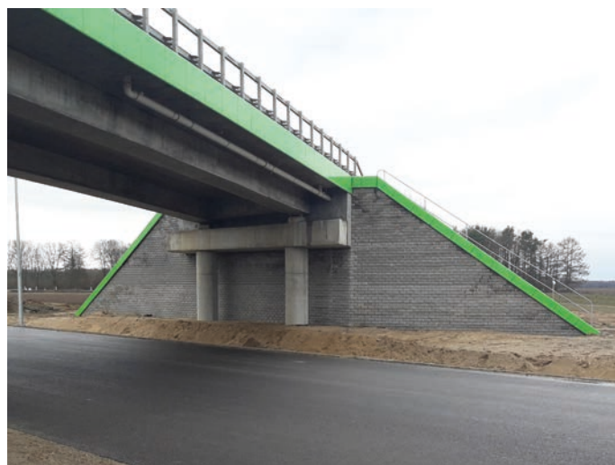
Rys. 15. Widok na przyczółek filarowy z zastosowaniem zapleczyń ścian oporowych z gruntu zbrojonego, P.R. INORA
