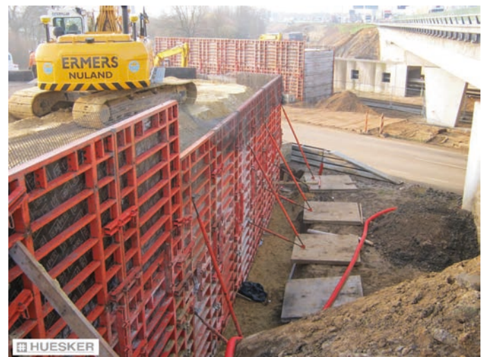
Rys. 5. Przykład systemowej konstrukcji szalunkowej na pełną wysokość bloku z gruntu zbrojonego, Huesker
