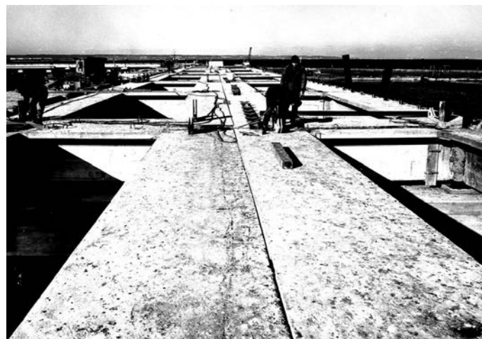
Rys. 8. Budowa Pirsu Rudowego w Porcie Północnym w Gdańsku; widok nadbudowy pirsu z okresu budowy (szkoda, że nie wykorzystanego zgodnie z przeznaczeniem)
