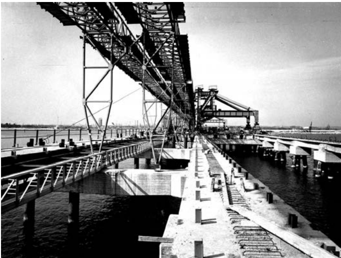
Rys. 5. Pirs Węglowy w Porcie Północnym w ostatniej fazie budowy i wyposażenia w specjalistyczne urządzenia
