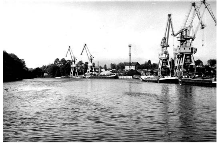
Rys. 3. Widok fragmentu portu rzecznego w Gliwicach
