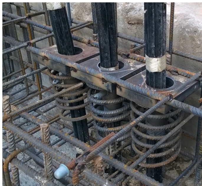
Rys. 8. Głowica zakotwienia czynnego
