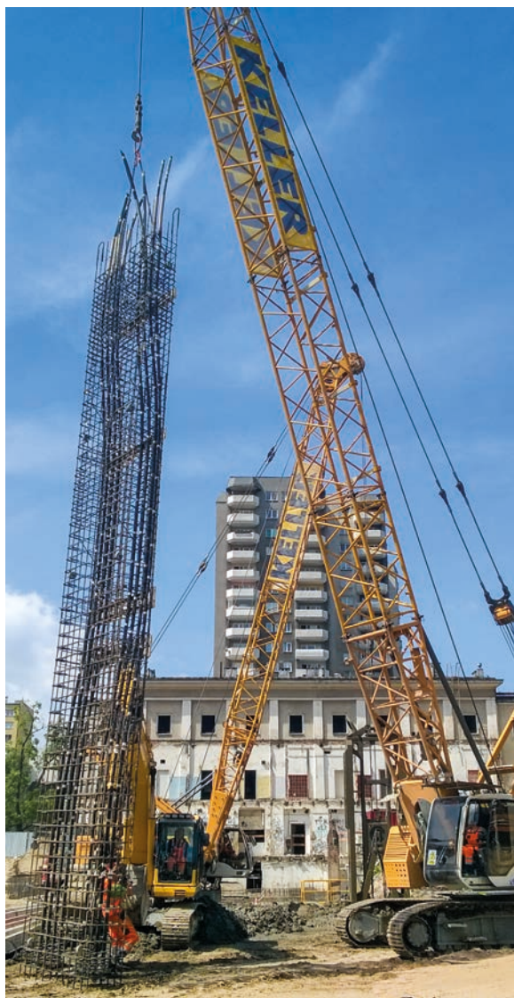
Rys. 13 Podnoszenie i instalowanie kosza zbrojeniowego z kablami sprężającymi
