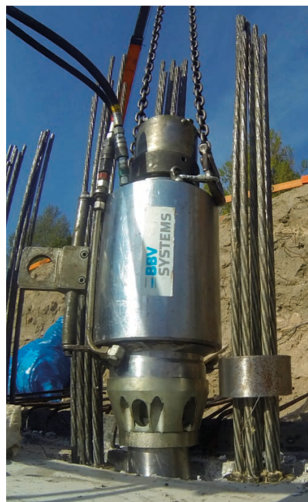
Rys. 14. Etap sprężania ściany szczelinowej prasą sprężającą BBV L7
