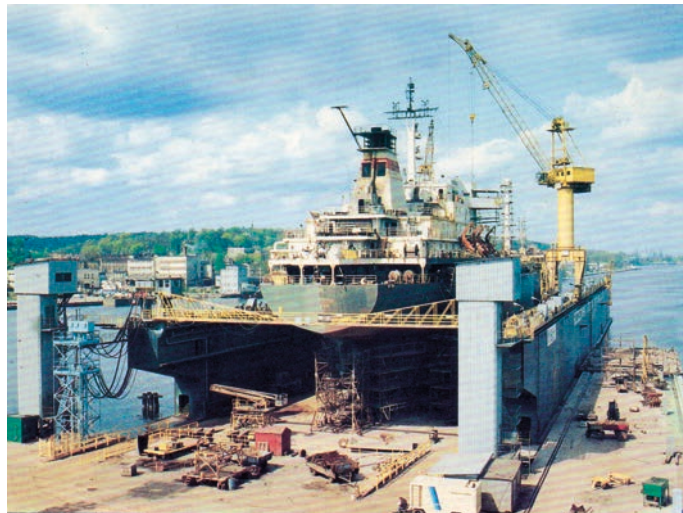
Rys. 3. Dok pływający o nośności 15 000 t w Stoczni Remontowej „GRYFIA” w Szczecinie – widok od strony lądu: bezpośrednio przed dokiem pomost Przydokowy, wieżyczka do przejścia instalacji zasilających dok oraz dwie windy transportowe
