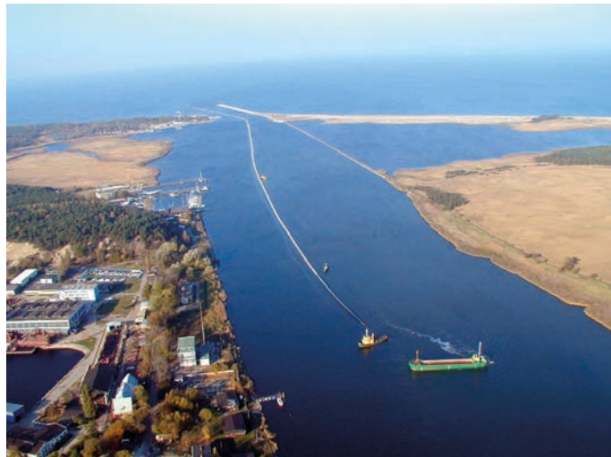
Rys. 15. Holowanie w rejonie ujścia Wisły scalonego rurociągu (z przeznaczeniem do zrzutu ścieków z oczyszczalni Gdańsk – Wschód)
