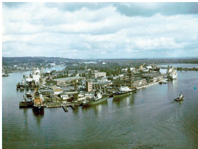
Rys. 4. Perspektywiczny widok części południowej (Wyspa Dolna Okrętowa) Stoczni Remontowej „GRYFIA” w Szczecinie; przed wyspą główny tor wodny Szczecin – Świnoujście
