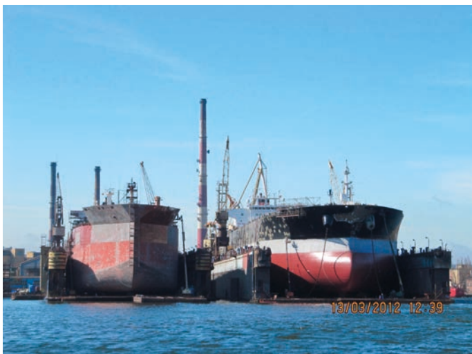
Rys. 2. Widok od strony akwenu na największe w Polsce doki pływające zlokalizowane w Gdańskiej Stoczni Remontowej; po lewej stronie dok o nośności 25 000 t, a po stronie prawej największy dok o nośności 33 000 t
