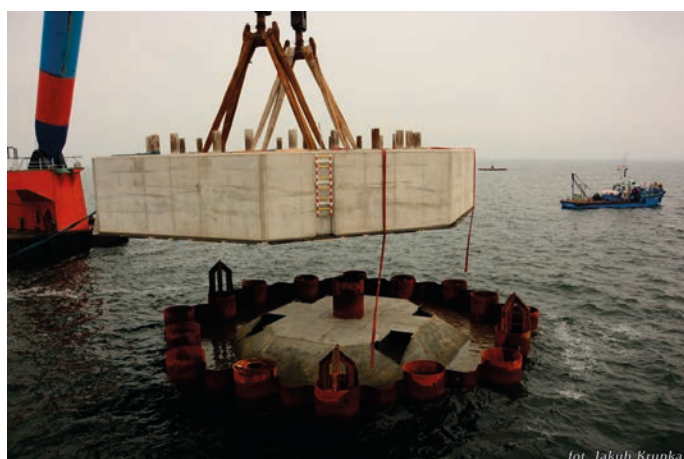
Rys. 18. Posadowienie dolnego prefabrykatu na części podwodnej znaku za pomocą dźwigu pływającego o udźwigu 900 t
