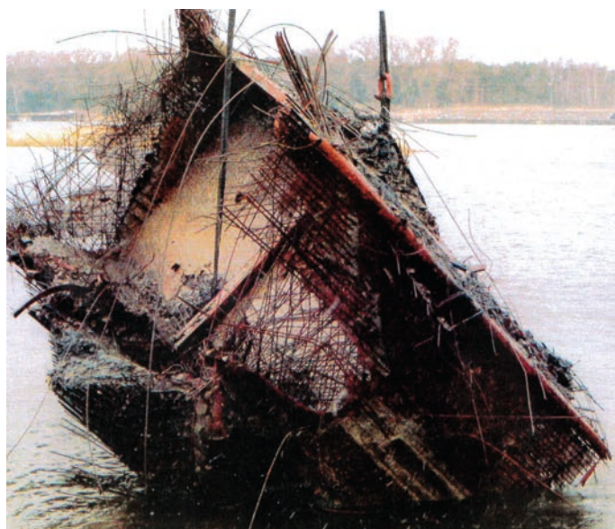
Rys. 16. Część wraku wydobytego do utylizacji, z rozciętej pod wodą metodą pirotechniczną barki (betonowe ściany z zagęszczonym zbrojeniem)
