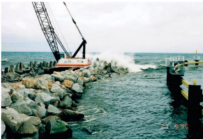
Rys. 13. Dalby prowadnicy dla statków i nadbudowę falochronu Zachodniego w ostatniej fazie robót w Porcie Leba
