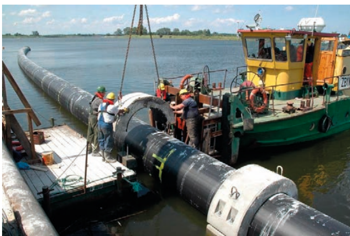
Rys. 14. Kolektor zrzutowy (z przeznaczeniem dla oczyszczalni Gdańsk – Wschód), unoszony na zawieszu podczas zakładania betonowych obciążników; rurociąg wykonany z rur polietylenowych PEHD DN 1 600 mm
