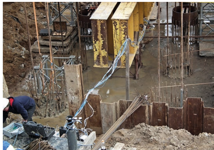
Rys. 2. Podłączanie układu ekstensometrycznego
