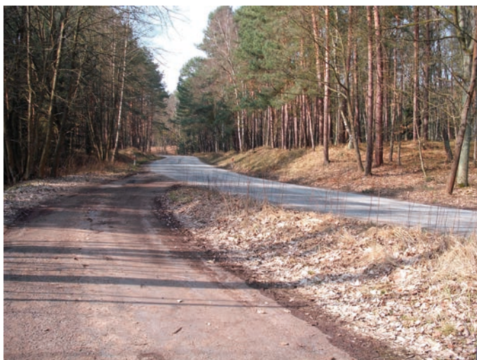
Rys. 4. Widok w kierunku zachodnim drogi nr 501 (w rejonie Nowego Światu) biegnącej wzdłuż Mierzei Wiślanej
