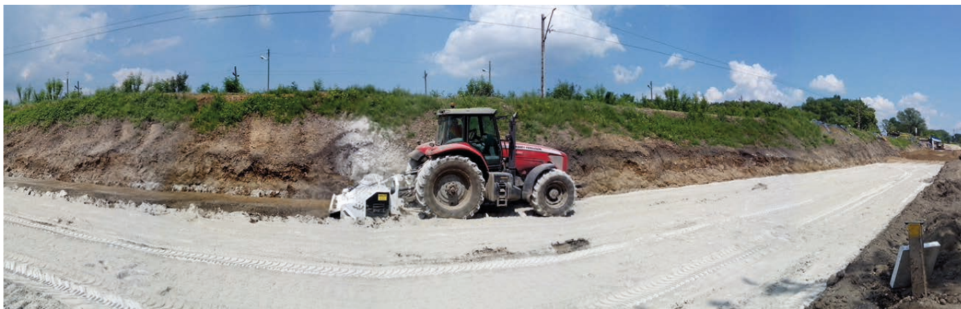
Rys. 5. Mieszarko-frezarka do stabilizacji gruntów na ciągniku rolniczym
