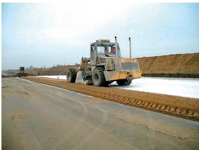
Rys. 4. Samojedzna mieszarko-frezarka do stabilizacji gruntów
