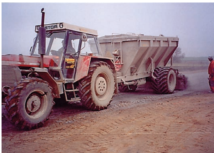
Rys. 3. Rozścielanie wapna palonego
