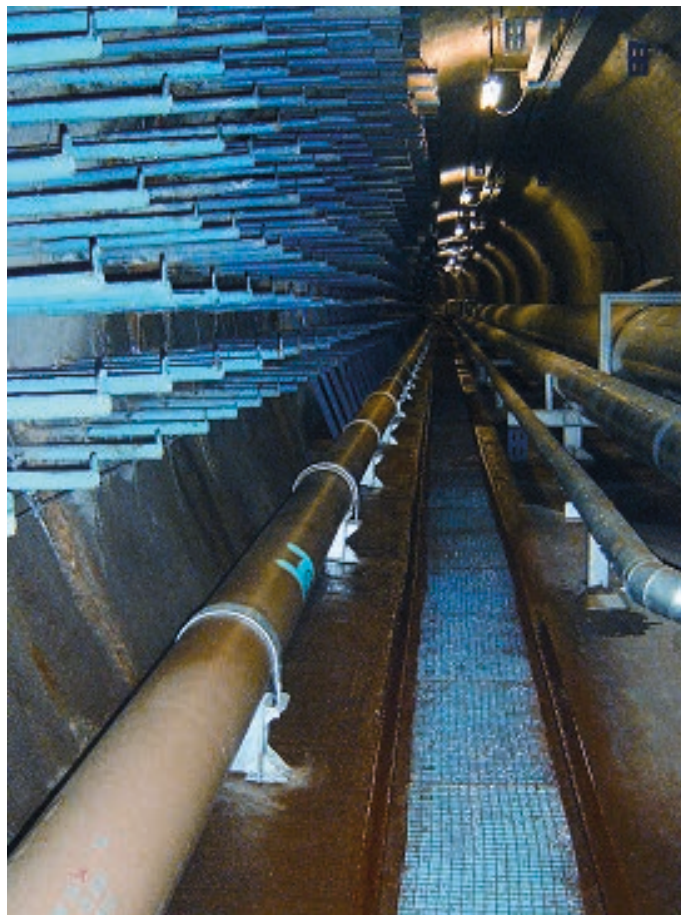
Rys. 8. Rurociąg (GRP) ułożony we wnętrzu tunelu, np. materiałów firmy HOBAS
