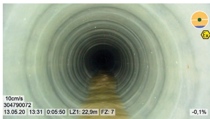
Rys. 2. Liner typu GRP DN 300 mm utwardzony promieniami UV (źródło: Raganowicz)
