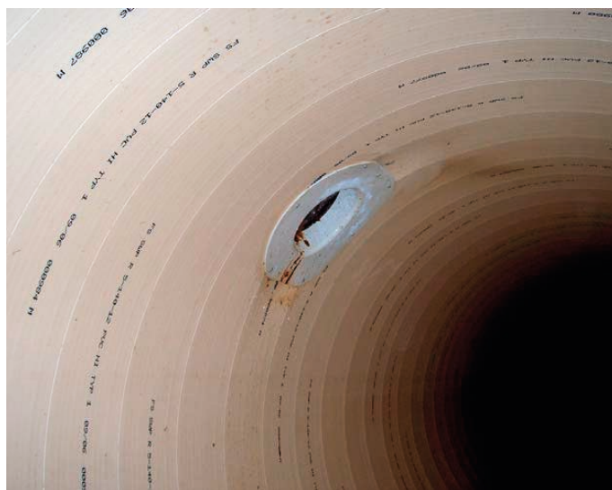
Rys. 5. Zakończenie przykanalika za pomocą systemu „SWP-hatform-fix (PVC)” [5]
