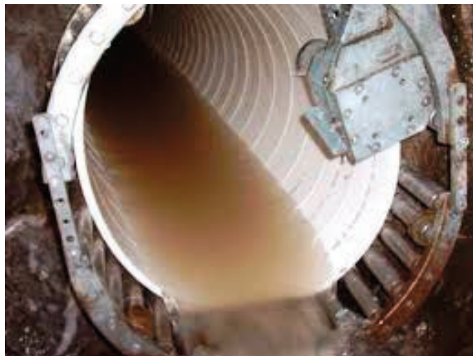
Rys. 4. Renowacja przewodu kanalizacyjnego techniką nawijającej się rury [5]
