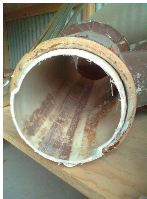
Rys. 1. Przewód kamionkowy z linerem na bazie żywicy epoksydowej (źródło: Raganowicz)
