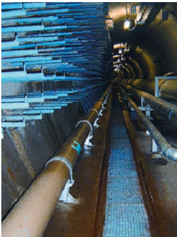
Rys. 6. Rurociąg posadowiony w tunelu będącym odpowiednikiem tradycyjnego wykopu, rury GRP, na przykład materiałów firmy HOBAS
