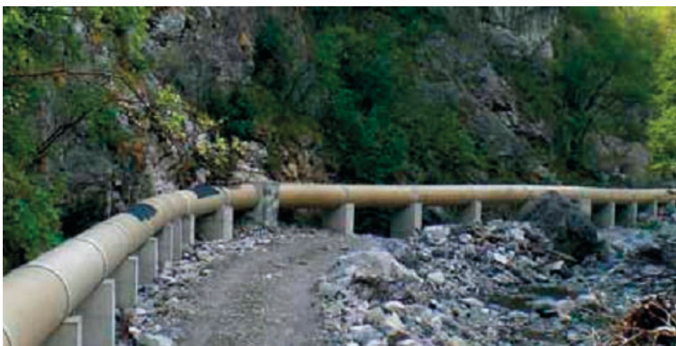
Rys. 9. Rurociąg ciśnieniowy – rury GRP, podparcie punktowe, na przykład materiałów firmy HOBAS
