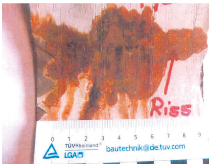
Rys. 5. Powiększenie środkowego uszkodzenia przedstawionego na rys. 4 [2]
