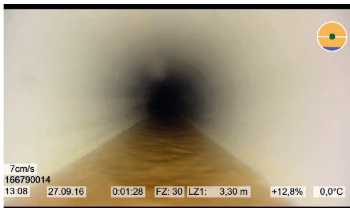
Rys. 8. Wnętrze przewodu transportowego po renowacji techniką Compact-Pipe (źródło: Raganowicz)
