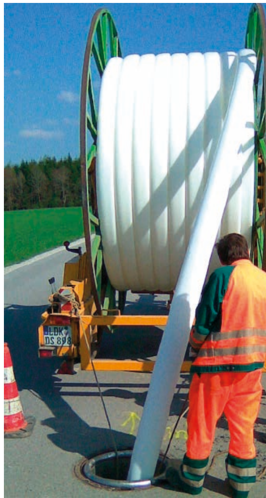
Rys. 6. Instalacja rękawa Compact-Pipe w ramach odcinka łączącego osiedle Kreuzpullach z przewodem głównym (źródło: Raganowicz)
