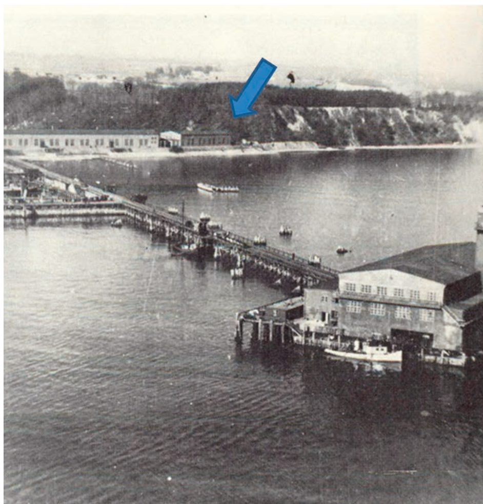
Rys. 9. Budynek torpedowani oddany do użytku w 1942 roku. Strzałką oznaczono przybliżone położenie KM 93,6 ÷ 93,9
