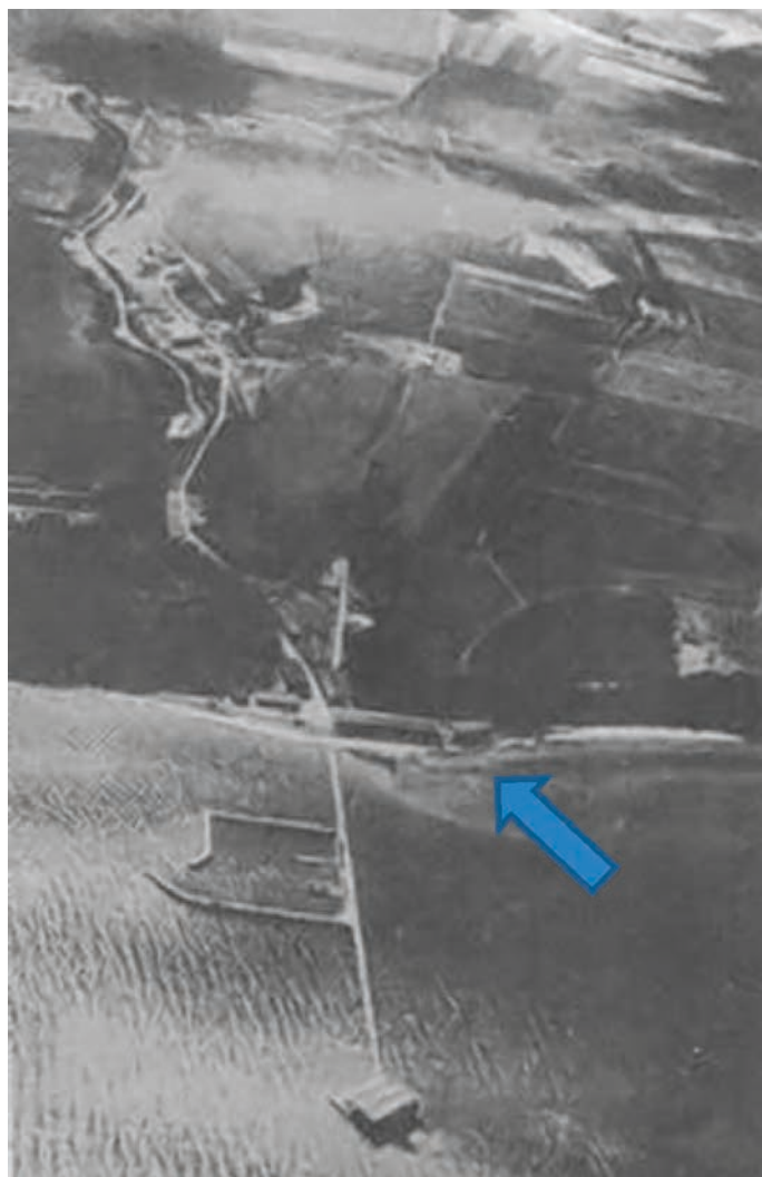
Rys. 10. Torpedownia oddana do użytku w 1942 roku. Strzałką oznaczono przybliżone położenie KM 93,6 ÷ 93,9
