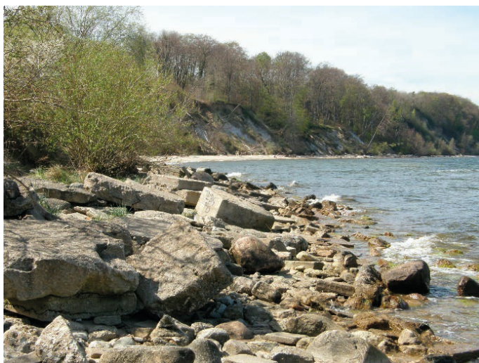
Rys. 4. Opaska narzutowa z gruzobetonu na KM 93,6 ÷ 93,9, stan morza 501 cm, godz. 13.00 UTC, 10.05.2021 r. (fot. R. Ostrowski)
