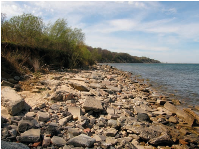
Rys. 1. Opaska brzegowa z gruzobetonu na brzegu morskim w rejonie Babich Dolów (KM 93,6 ÷ 93,9)
