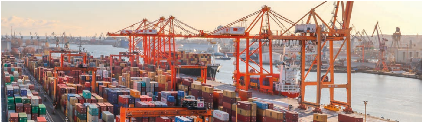
Rys. 2. Bałtycki Terminal Kontenerowy w Porcie w Gdyni [16]
