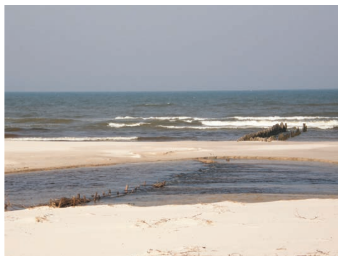
Rys. 1. Pozostałości palisadowo-kamiennych konstrukcji w ujściu rzeki Piaśnicy (km 149,13), 2018 rok (fot. R. Ostrowski)
