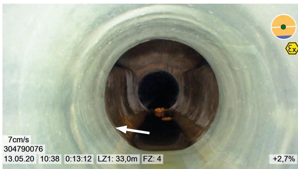
Rys. 4. Zakończenie rękawa w studzience rewizyjnej-
